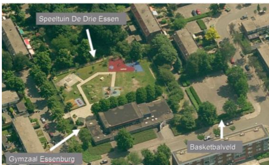
Afbeelding 4.1 Luchtfoto van de locatie aan de Essenburg in Ede, situatie voor herinrichting
